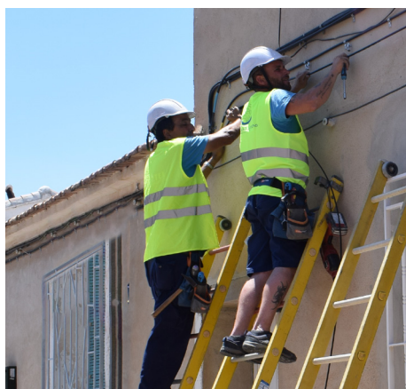
Técnicos realizando una instalación.
