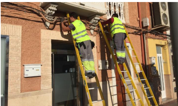
Técnicos desplegando fibra óptica.
